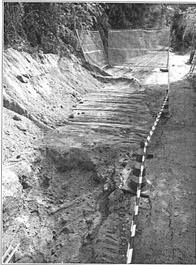
Figura 11 - Immagine del materiale di riempimento dello scavo (inerti con KEU) in Via Gioielli (foto fornita da Ingegnerie Toscane S.r.l.).
