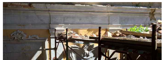
Viste del Salone centrale a doppio volume con il ponteggio realizzato nel 2008 a protezione dai crolli della copertura attualmente crollata
