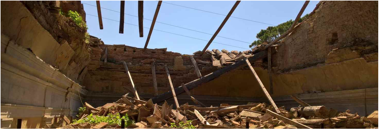
Vista dello stato attuale della volta e della copertura crollata del Salone
