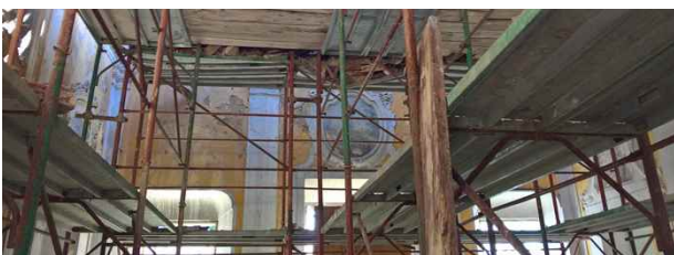
Viste del Salone centrale a doppio volume con il ponteggio realizzato nel 2008 a protezione dai crolli della copertura attualmente crollata
