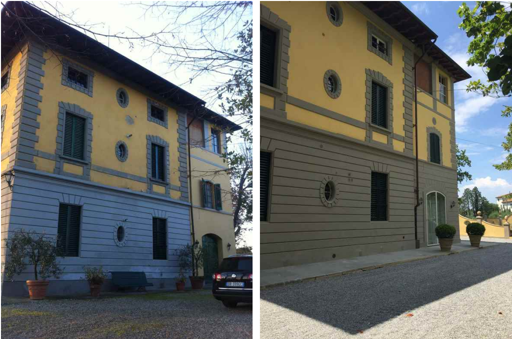
Vista della facciata laterale est prima e dopo l'intervento di recupero di villa Rey
