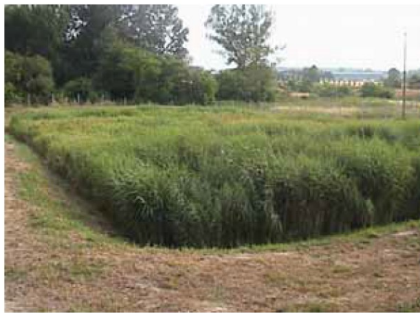
Figura 4 - Sistema di fitodepurazione al servizio della Cantina Cecchi & Figli (Castellina in Chianti – SI)
