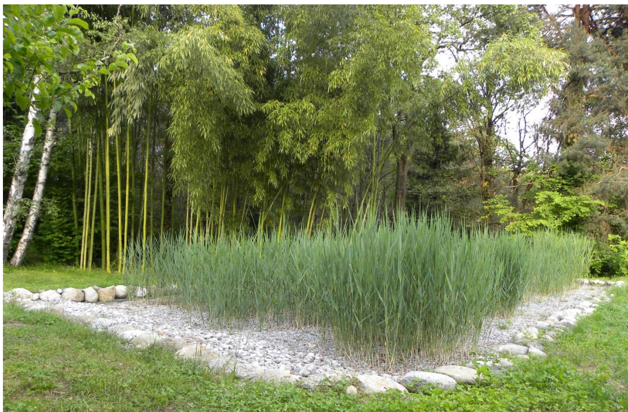
Immagine 14. Esempio di sistema d fitodepurazione
