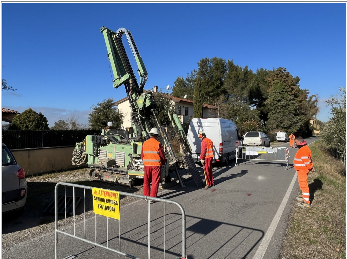
Figura 3 - Foto della realizzazione del sondaggio inclinato S8.
