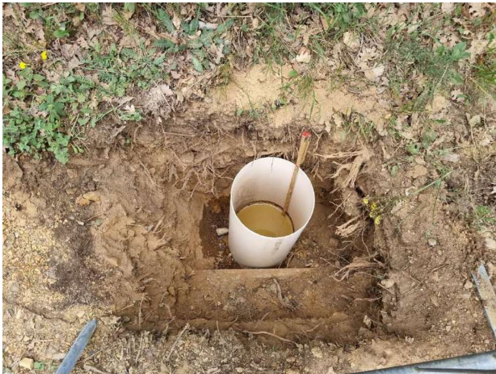
Figura 3 - Dettaglio prova di permeabilità n.2, tubazione vecchia rete acquedottistica.
