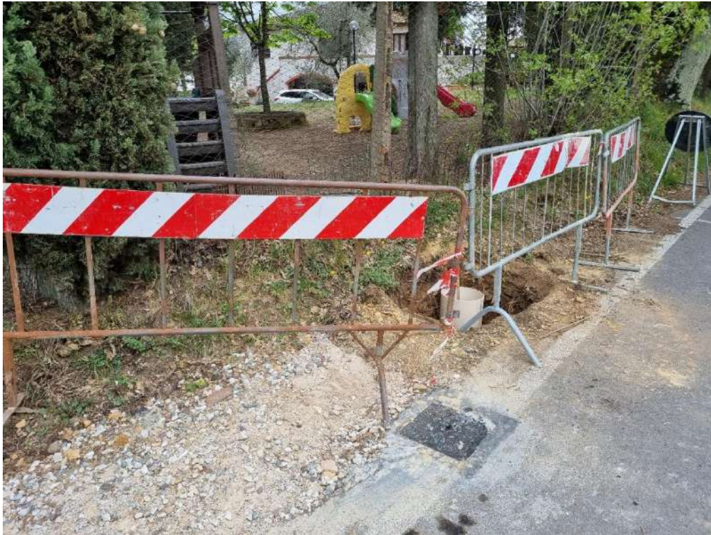
Figura 2 - Area di cantiere prova di permeabilità n.2. Pozzetto carrabile attrezzato con piezometro 2.
