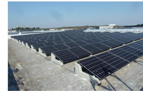
Sistema di supporto per impianto fotovoltaico costituito da zavorre in cemento per inclinazione modulo 30°
